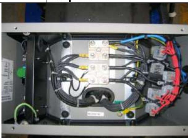
Рис.5 Регулятор напряжения
