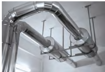
Монтаж выхлопной системы (рис. 17).
