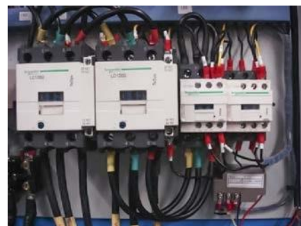
Рис. 8 Концы входного провода электропитания
