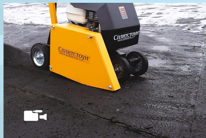
Достаточная ширина шва не допускает схождения кромок. Лёгкая регулировка глубины реза 0-100 мм.
